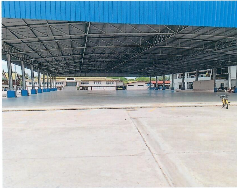
๑๐. โดมสำหรับออกกำลังกายเช่น เต้นแอโรบิค วิ่ง ฟุตซอล กีฬาพื้นบ้าน หมู่ที่ ๑ ตำบลบางหัก อำเภอพานทอง จังหวัดชลบุรี
