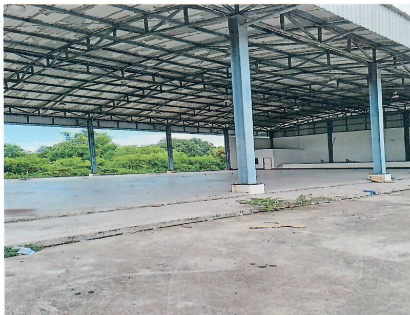
๙. โดมสำหรับออกกำลังกายเช่น เต้นแอโรบิค วิ่ง กีฬาพื้นบ้าน หมู่ที่ ๖ ตำบลเกาะลอย อำเภอพานทอง จังหวัดชลบุรี
