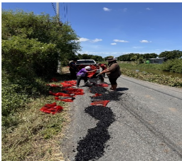
งานซ่อมแซมถนนยางมะตอย (วัสดุก่อสร้าง) (ข้อบัญญัติ 2567)
