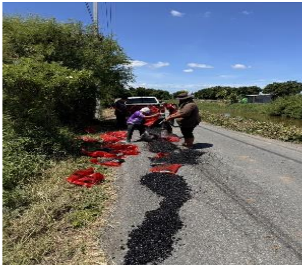
งานซ่อมแซมถนนยางมะตอย (วัสดุก่อสร้าง) (ข้อบัญญัติ 2567)
